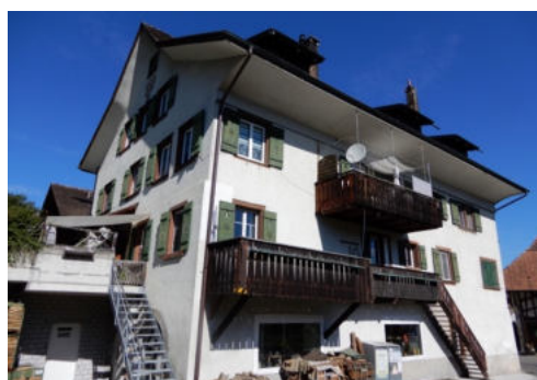
Ansicht von Südosten (Bild SKW)
