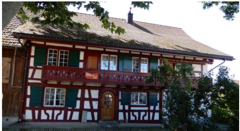
Ansicht Wohnteil von Süden (Bild SKW)
