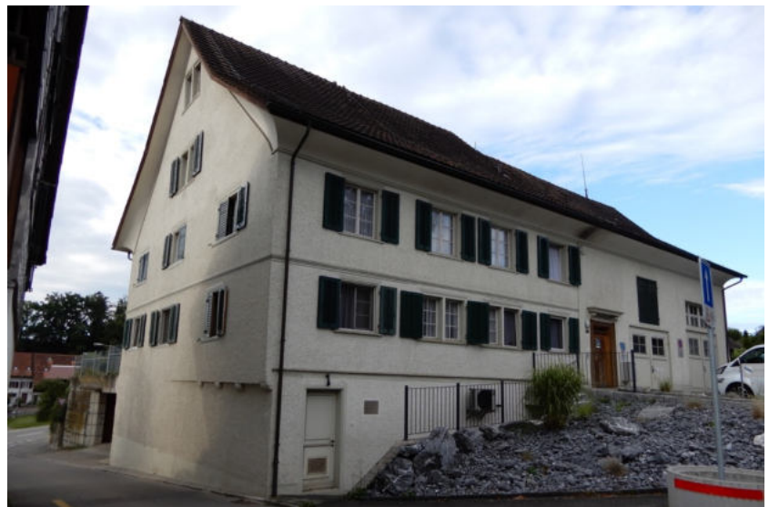
Ansicht von Nordosten (Bild SKW)
