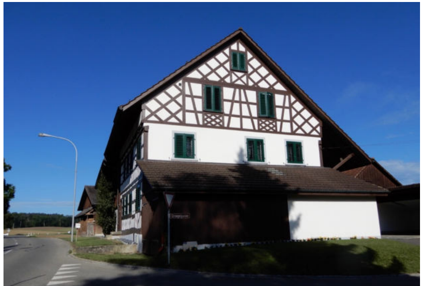
Hauptgebäude (Assekuranz-Nr. 69): Ansicht von Südosten (Bild SKW)
