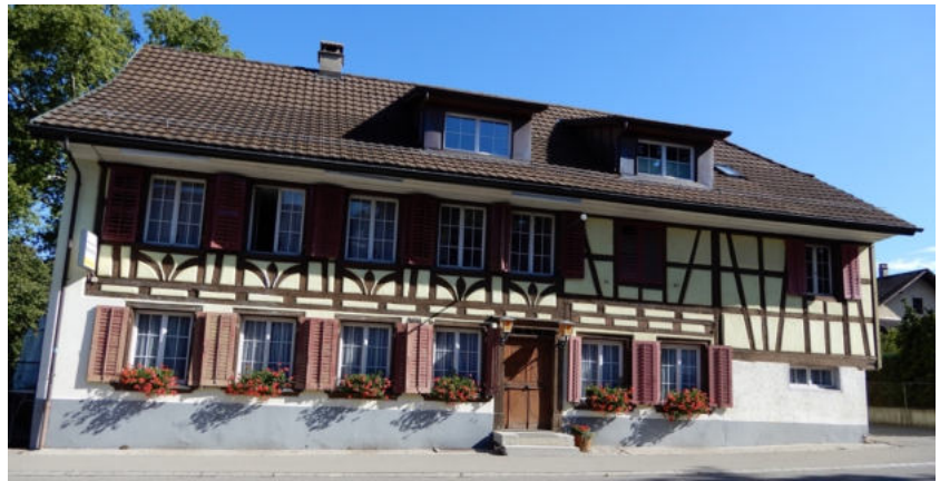
Ansicht von Süden (Bild SKW)
