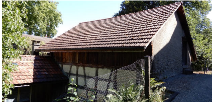
Ansicht Scheune / Schopf von Südwesten (Bild SKW)
