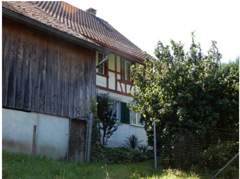
Ansicht von Südosten (Bild SKW)
