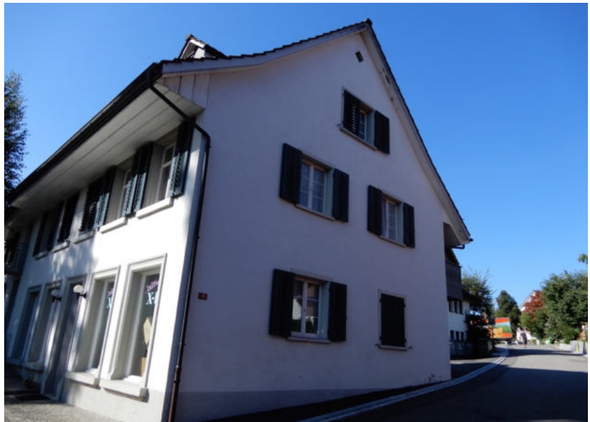
Ansicht von Nordosten (Bild SKW)
