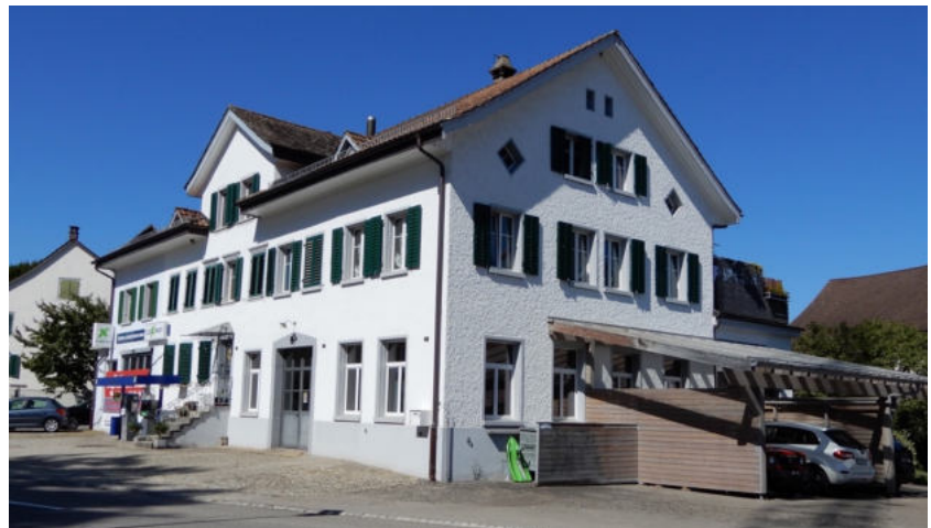
Ansicht von Südosten (Bild SKW)
