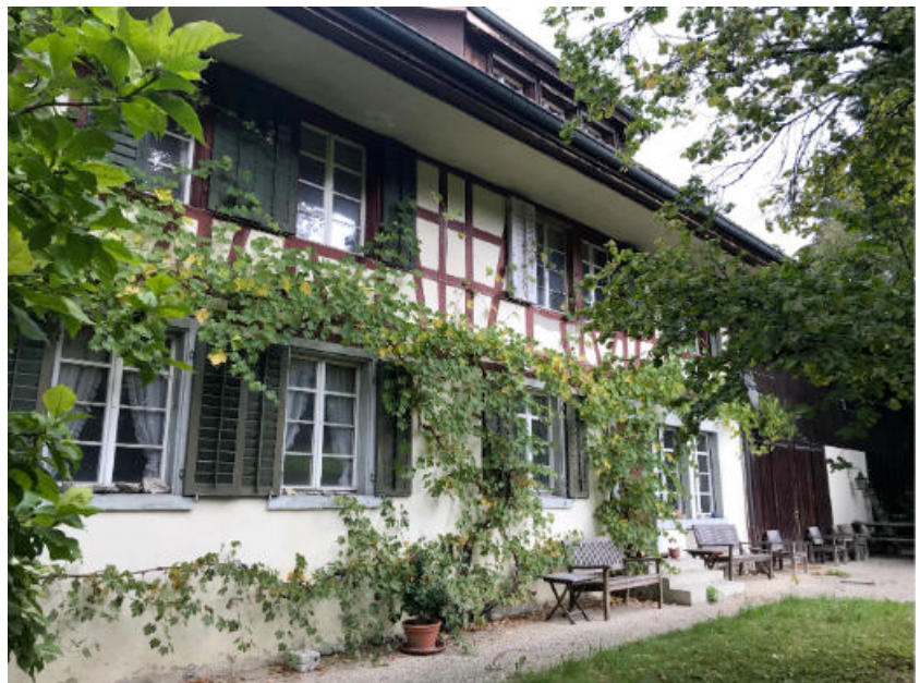
Ansicht von Süden (Bild SKW)
