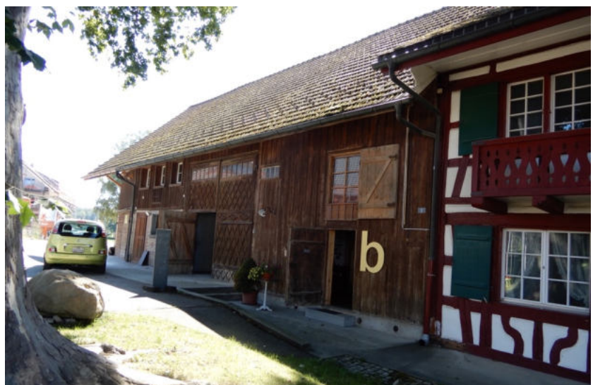
Ansicht Scheunenanbau von Süden (Bild SKW)
