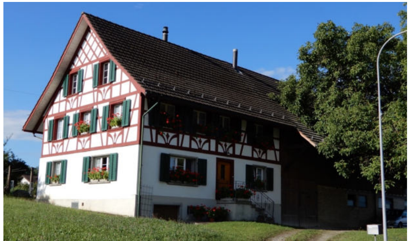
Ansicht von Nordosten (Bild SKW)
