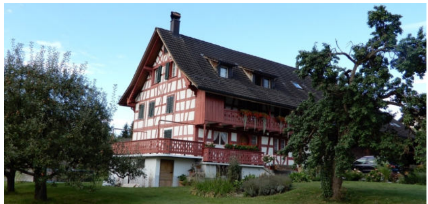
Ansicht von Nordosten (Bild SKW)
