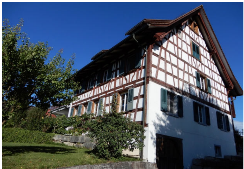
Ansicht von Südosten (Bild SKW)
