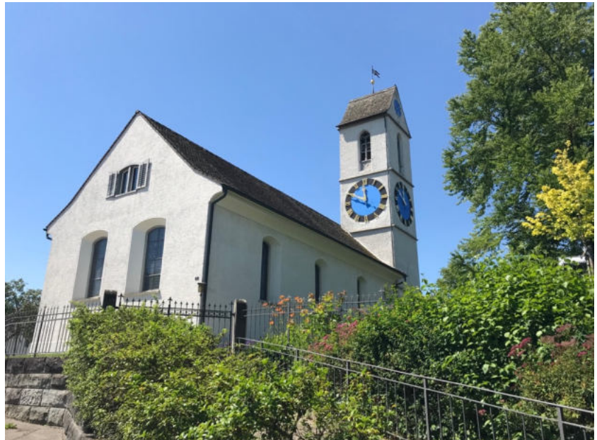
Ansicht von Nordosten (Bild SKW)
