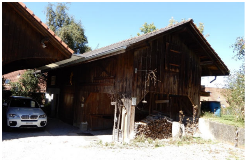
Ansicht Nebengebäude von Südosten (Bild SKW)
