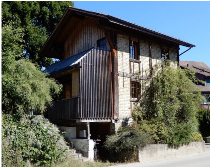
Ansicht von Süd-West (Bild SKW)
