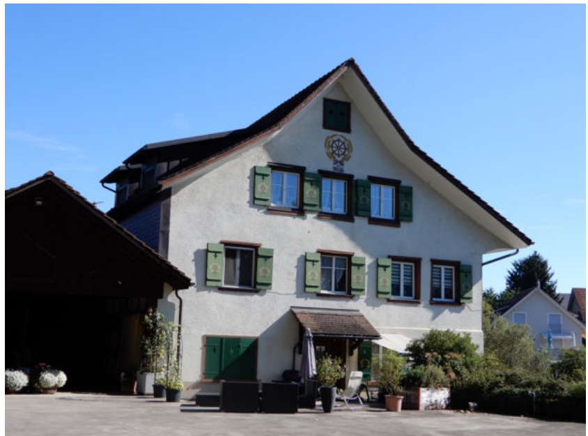
Ansicht Wohngebäude von Süden und ehem. Sägerei (links) (Bild SKW)
