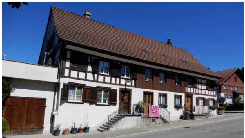
Ansicht von Süden (Bild SKW)
