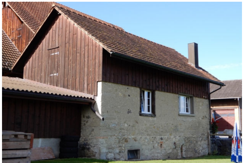
Scheune (Assekuranz-Nr. 70): Ansicht von Nordosten (Bild SKW)
