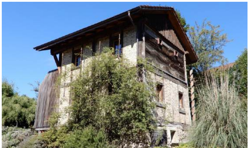
Ansicht von Süd-Ost (Bild SKW)
