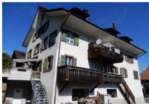
Ansicht von Südosten (Bild SKW)
