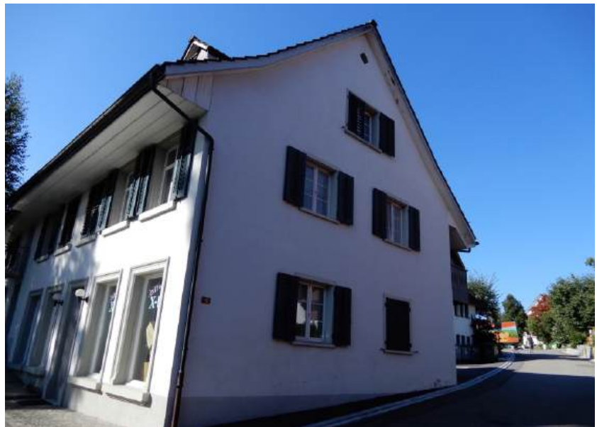
Ansicht von Nordosten (Bild SKW)
