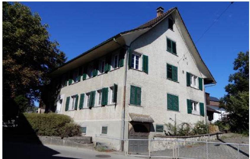
Hauptgebäude (Objekt Assekuranz-Nr. 55): Ansicht von Südosten (Bild SKW)
