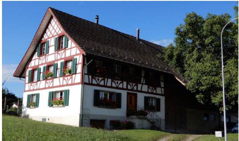
Ansicht von Nordosten (Bild SKW)
