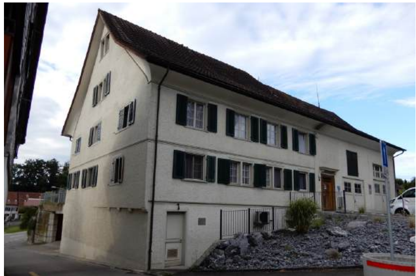
Ansicht von Nordosten (Bild SKW)
