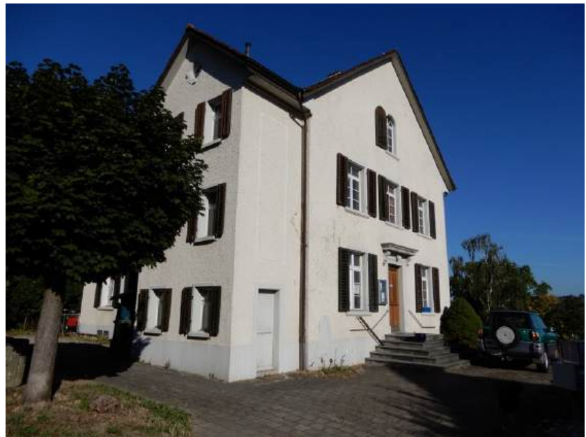
Ansicht von Südosten (Bild SKW)
