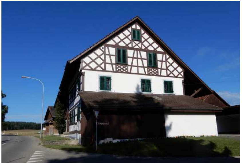
Hauptgebäude (Assekuranz-Nr. 69): Ansicht von Südosten (Bild SKW)
