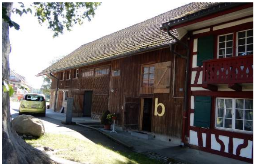
Ansicht Scheunenanbau von Süden (Bild SKW)
