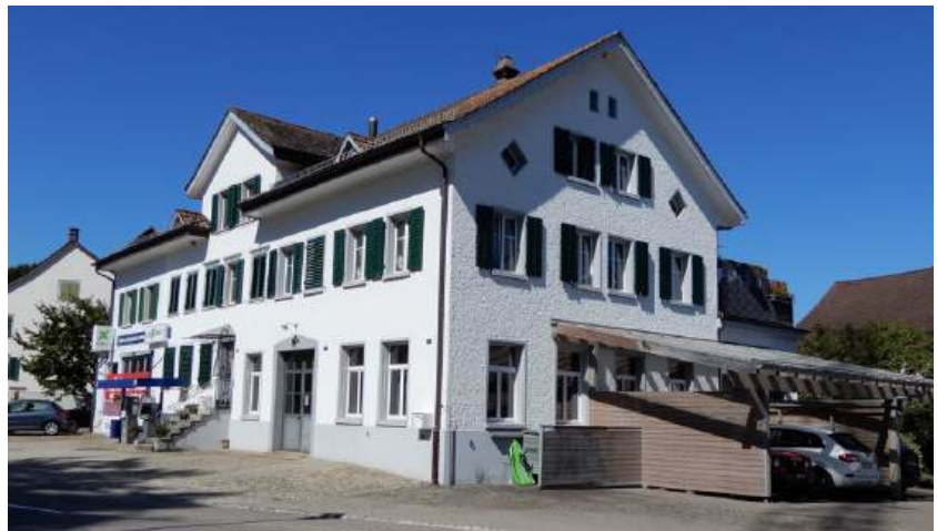
Ansicht von Südosten (Bild SKW)
