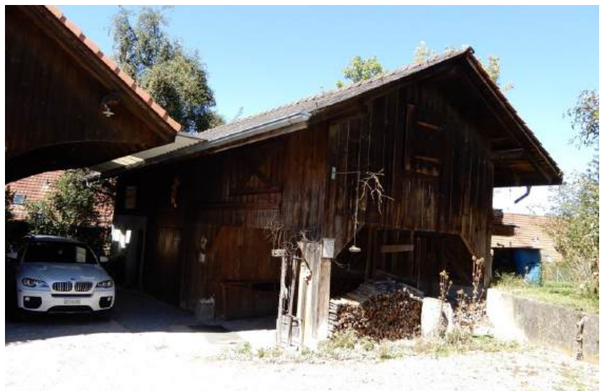
Ansicht Nebengebäude von Südosten (Bild SKW)
