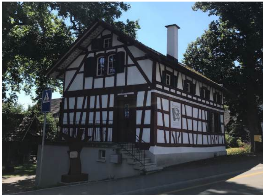
Ansicht von Nordwesten (Bild SKW)
