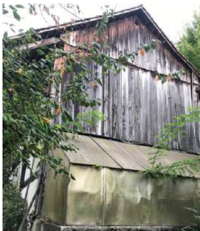
Ansicht Nebengebäude (Bild SKW)
