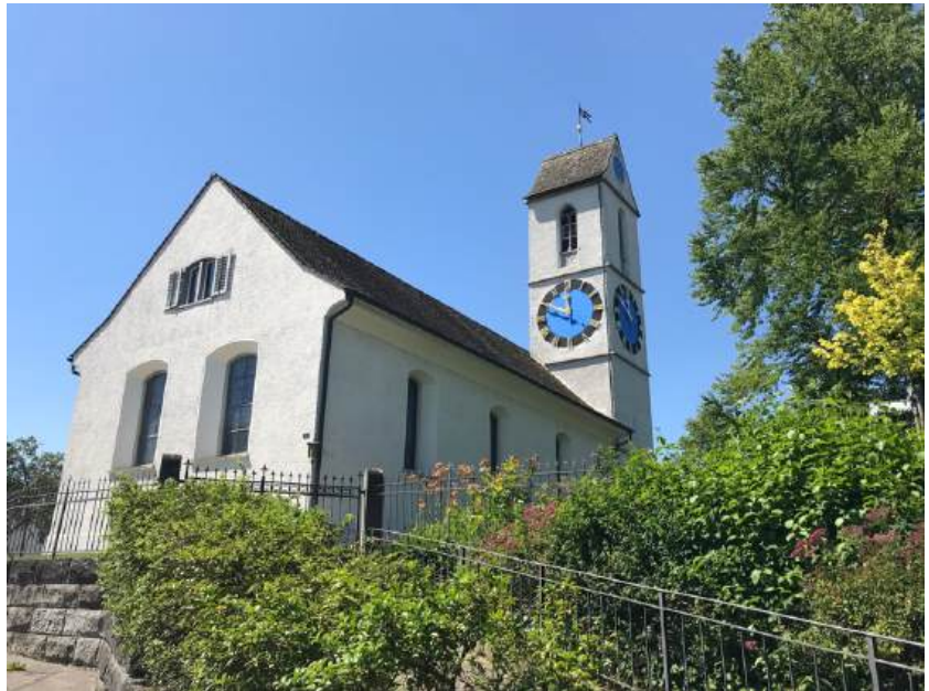
Ansicht von Nordosten (Bild SKW)
