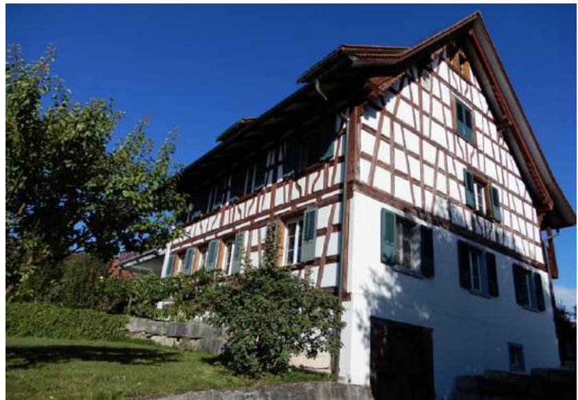
Ansicht von Südosten (Bild SKW)
