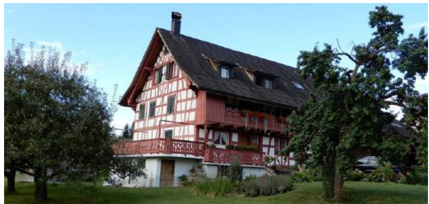
Ansicht von Nordosten (Bild SKW)
