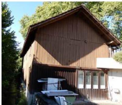
Ansicht Mühle von Nordosten (Bild SKW)
