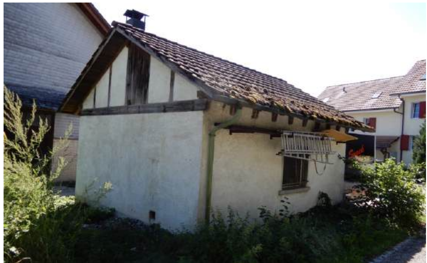
Waschhaus (Objekt Assekuranz-Nr. 176): Ansicht von Nordwesten (Bild SKW)
